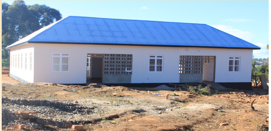
Jengo la Zahanati ya Ramadhan inayojengwa kupitia Mpango wa Kunusuru Kaya Maskini TASAF III ambalo lipo katika hatua za umaliziaji
