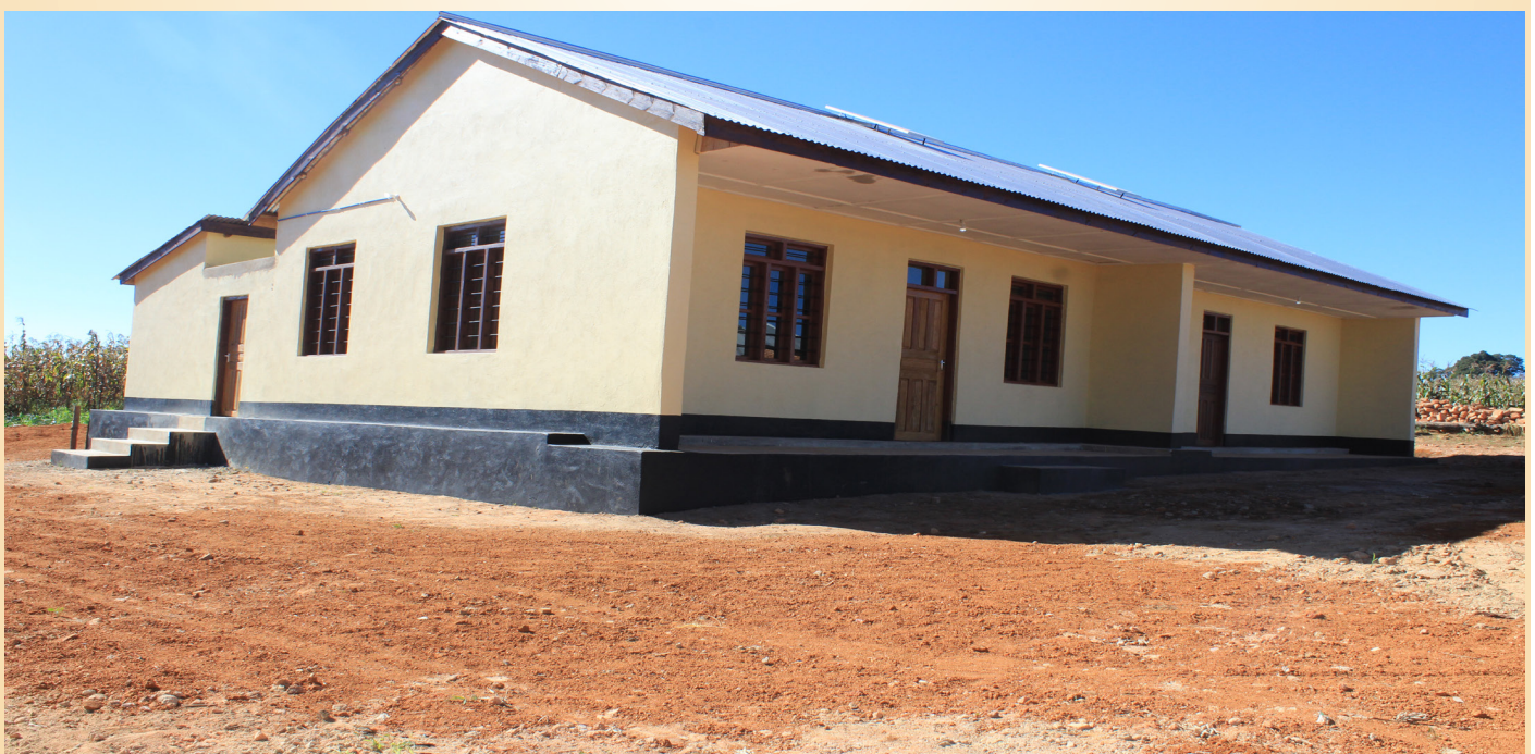
Muonekano wa nyumba ya mwalimu katika shule ya msingi Umoja iliyopo katika Kijiji cha Lugenge Kata ya Lugenge Halmashauri ya Mji Njombe iliyojengwa kupitia mpango wa kunusuru kaya maskini TASAF III.
